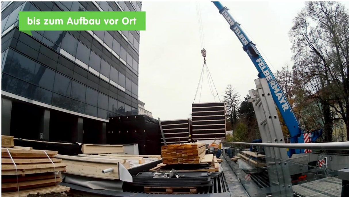
(Abb. 11 in Minute 00:39) (Aufbau Kran)
